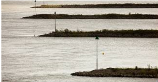
Haakse kribben in de Waal (bron: https://beeldbank.rws.nl , Rijkswaterstaat, Ruimte voor de Rivier)
